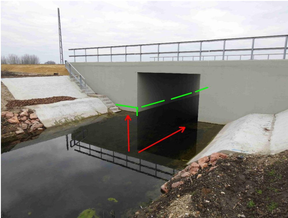
3. ábra: Vidrák és egyéb emlősök számára kedvezőbb műszaki kialakítású hid egy állandó vízzel ellátott csatornán.
